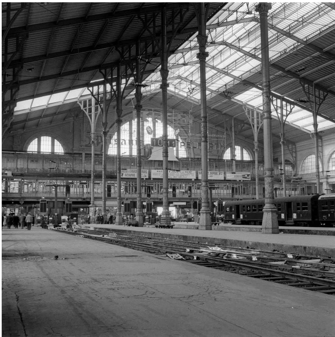
Les quais de la gare de Paris-Nord. © SNCF Médiathèque - Debeauce
